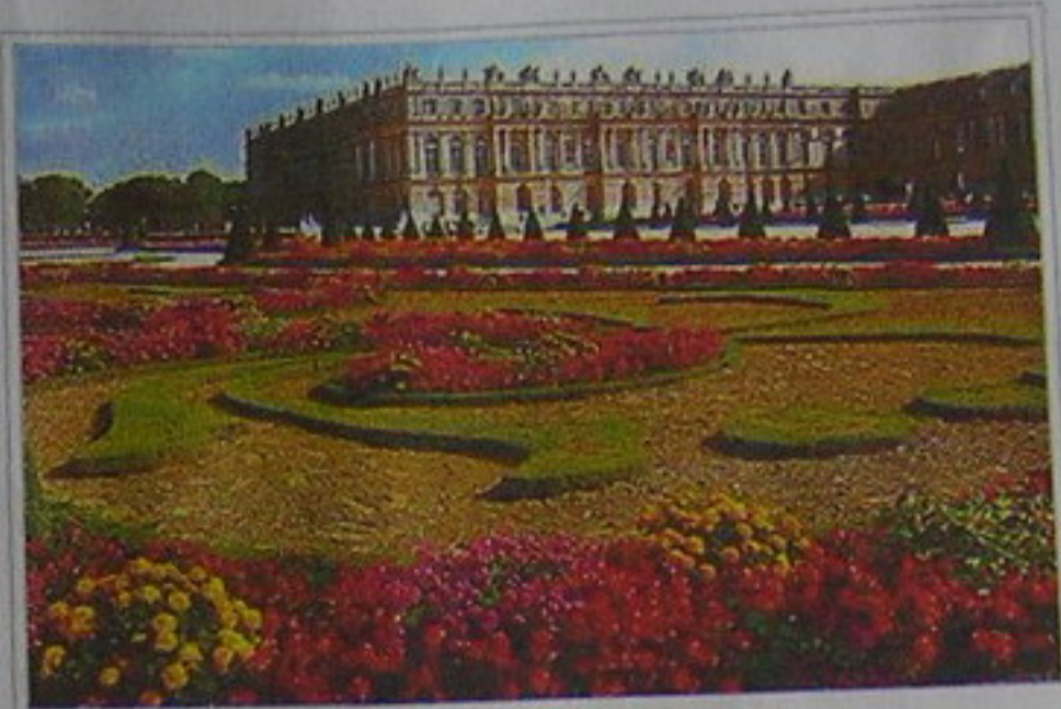
Versalles. Fachada sudoeste.
